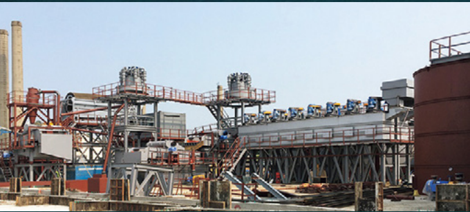
다이옥신 오염토양 세척 공사
