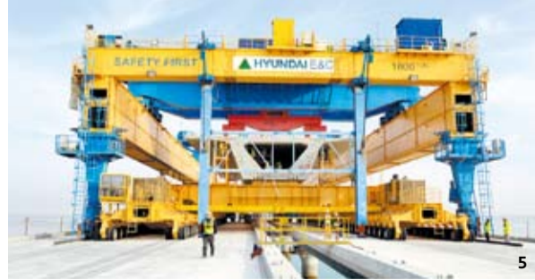
1 쿠웨이트 셰이크 자베르 코즈웨이는 슈웨이크 자유무역 지역과 북부 지역 수비아를 가로지르는 36.1km의 초장대교량이다. 2 현장은 33만㎡ 규모의 인공섬 2개소(북쪽/남쪽)도 공사했다. 사진은 남섬. 3 드론으로 촬영한 현장 전경. 4 공사에는 2200t급 플로팅 크레인(크레인)과 론칭 갠트리 등 각종 중장비가 사용됐다. 5 FSLM 공법으로 콘크리트 박스 거더를 설치하는 모습. 6 현장은 일반 건물의 높이를 뛰어 넘어 최대 길이 70m(직경 2.5~3m)의 해상교각 116개소를 설치했다.
