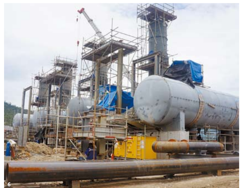
1 SIL Site 야경. 오지에 위치한 현장의 특성 상 밤에는 사물라 지열발전소 현장만이 불을 밝힌다. 2 준공한 NIL Site 전경. 3 열 교환기 설치 모습. 4 근로자들이 스팀터빈발전기를 설치하고 있다. 5 2016년 2월 시공의 SIL Site. 공행식 용축기(ACC)와 변전소(Switch Yard)를 한창 시공 중이다. 6 물과 증기를 나누는 기수분리기(Separator) 설치 모습. 7 화산토로 이뤄진 연막 지반을 보강하기 위해 지반 개량 공법(DCM)을 적용하고 있다.
