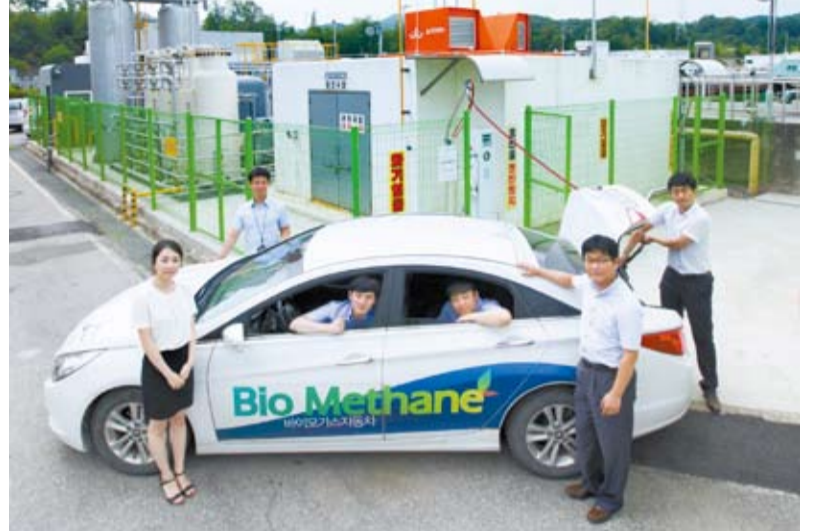
우리 회사가 원주 하수처리장에 건설한 바이오가스 정제시설과 차량연료 주입시설.
