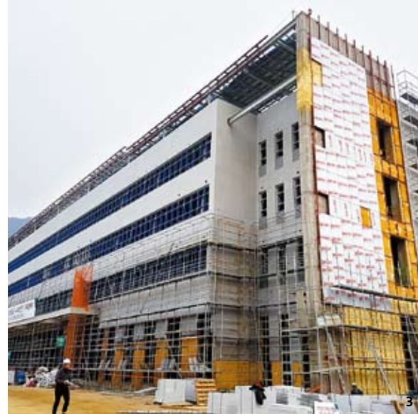
1 광활한 규모가 인상적인 소방방재 교육연구단지 현장 전경. 2 실내 종합 훈련장 1층 바닥 슬래브(Slab)에 콘크리트를 타설하고 있다. 3 행정동 외부 판넬 시공 모습. 4 근로자들이 바닥 슬래브의 철근 배근(配筋)을 검측하고 있다. 5 전입도로 이스탈트 콘크리트 포장 최종 작업 모습.
