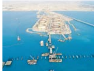
쿠웨이트 알주르 엘엔지 수입항 현장 전경.
