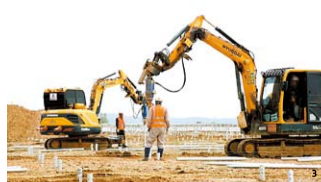
1 서산 태양광 발전소 전경. 2 태양광 패널을 설치하는 모습. 3,6 태양광 모듈 하부 구조물을 기반에 설치하고 있다. 4 에너지 저장 설비(ESS)가 들어설 건물. 5 태양광 모듈 약 18만5000여 장이 설치돼 있다.
