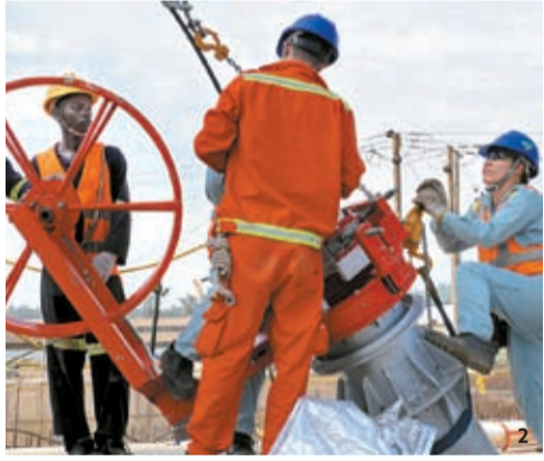
1 사장교 배합 후 기준에 설치된 이동식 거푸집(Form Traveller)을 제거하기 위해 앵커(Anchor)를 해제하고 있다. 2, 4 강철을 꼬아 만든 스트랜드를 모노 잭으로 긴장하는 방식인 MS 공법으로 케이블을 설치하고 장력을 조절하는 모습. 3 절속도로 공사를 위해 노상 작업을 하고 있다.
