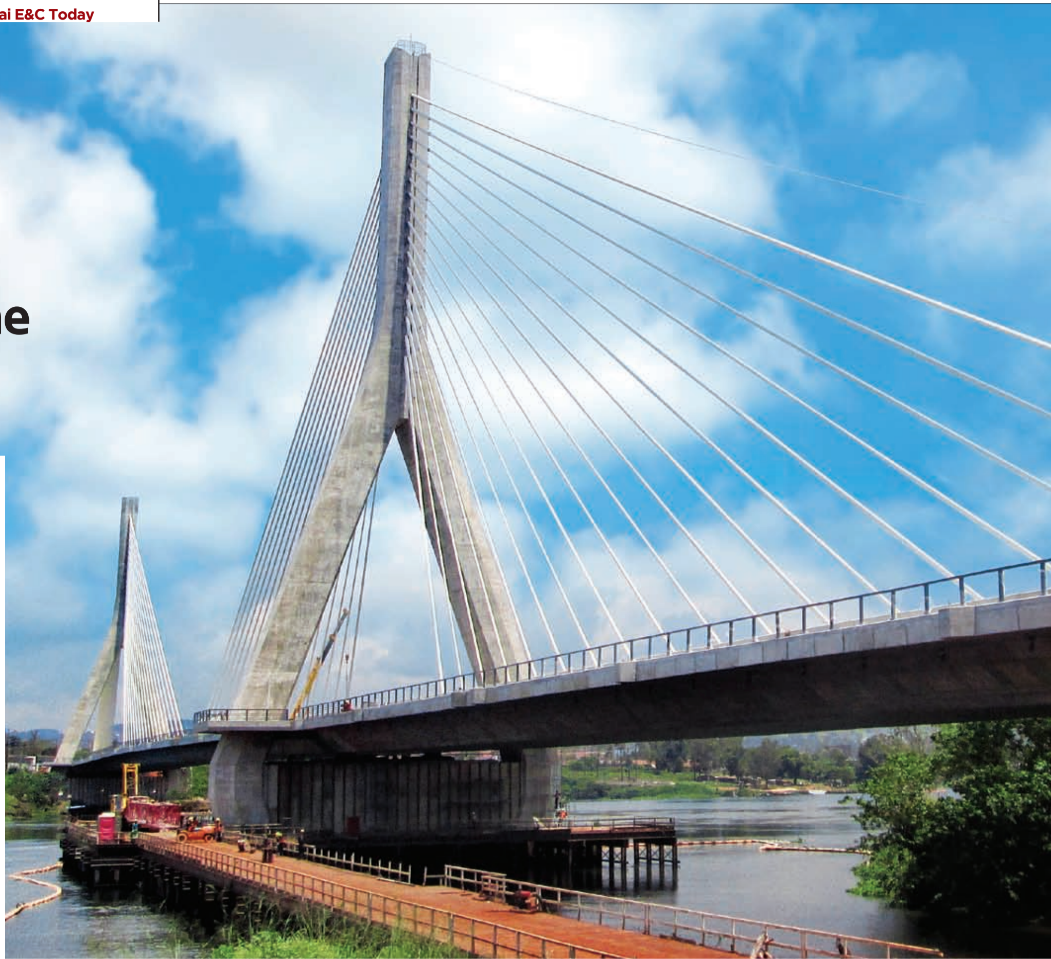
5 오는 10월 말 개통 예정인 우간다 진자교량 전경. 6 지난 3월 드론으로 촬영한 사장교가 폐합되기 전의 모습. 7 콘크리트 구조물인 주탑에는 자동상승 발판 거푸집 공법을 적용했다.
