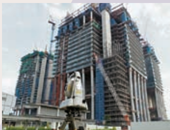
싱가포르에 위치한 마리나 사우스 복합개발 현장에서 한 직원이 3D 토털스테이션을 활용해 공사 진행상황을 측정 중이다.
