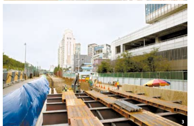
1 서부간선 지하 도로 공사 현장. 상하층 2층 4차로 터널 공사 중이다. 2, 3 지상에서 지하로 들어가는 터널 개착 구간 공사. 복공판을 설치하고 기존의 차로를 이동해 공사하고 있다. 4 터널 발파 천공 작업 모습.
