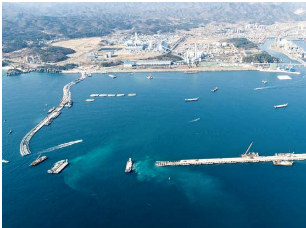
동해항 3단계 방파호안(1공구) 축조공사 현장
