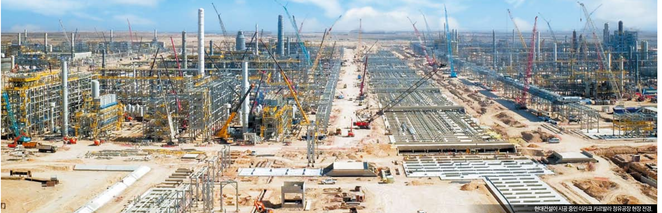
현대건설이 시공 중인 이라크 카르발라 정유공장 현장 전경.
